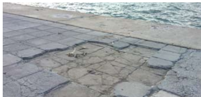
Μέγαρο Μουσικής 2009 - το πεζοδρόμιο ανατολικά. Η ίδια κατάσταση υπήρχε και πριν πέντε χρόνια, όπως φαίνεται στην φωτογραφία, αλλά οι αρμόδιοι κωφεύουν...
